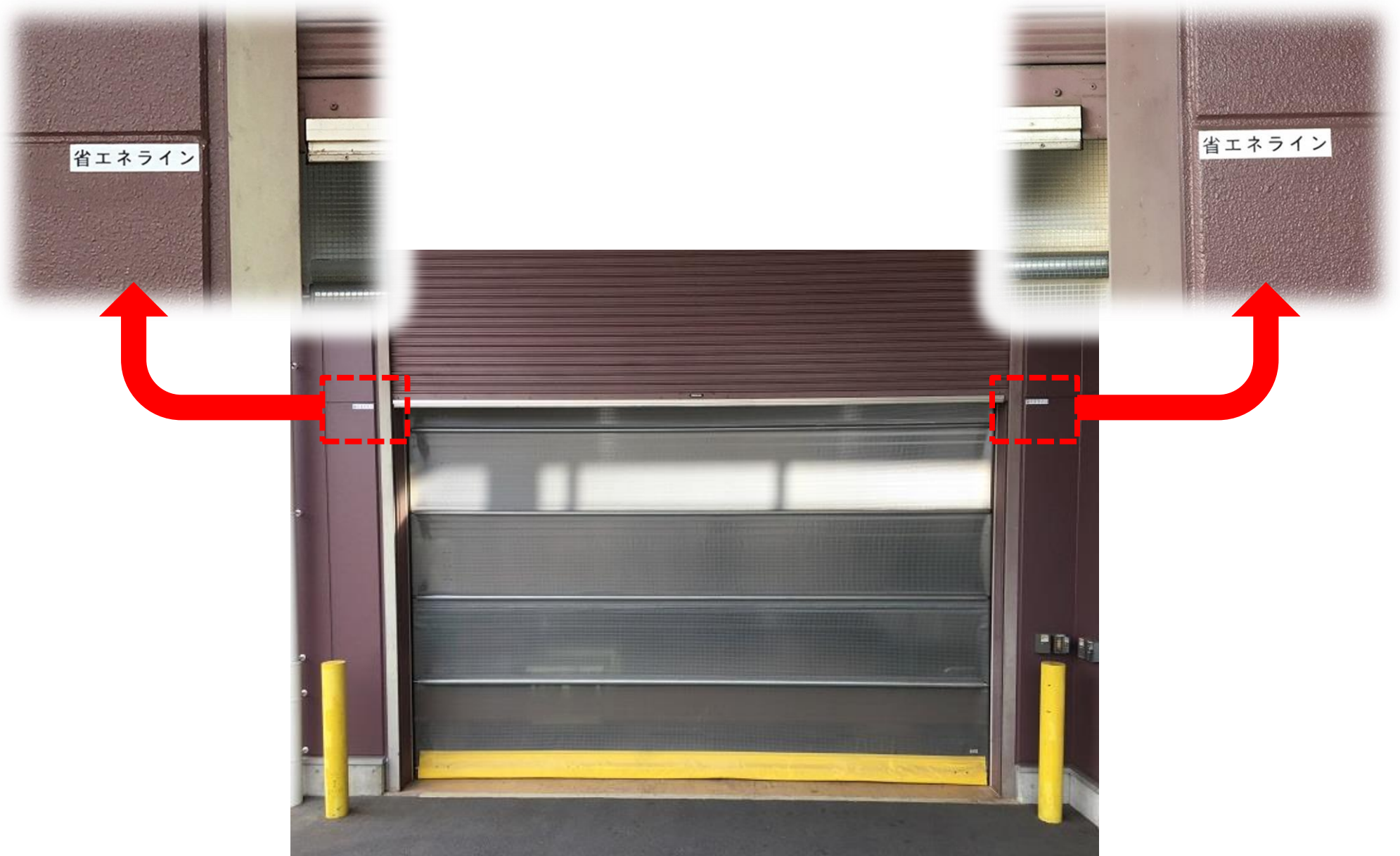
当社けいはんな工場 A3棟 シャッター
