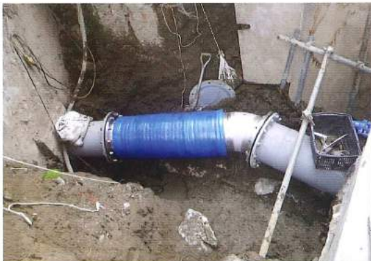
限られた空間で配置するために、 シナプスフレキと曲管を溶接により一体化
