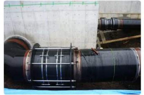
手前Φ1500 奥Φ800 配管仕様に合わせ タイロッド付と無を2台使用
