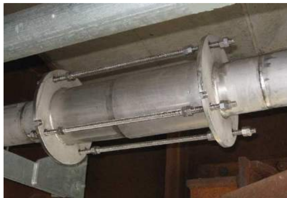
φ 150RTLS 桁内添架管で使用
