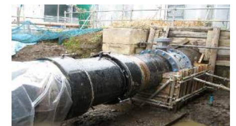
Φ900 管路耐震化工事に使用
