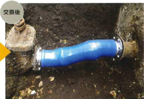
実際の配管形状に合わせた製品 さらなる沈下吸収も可能
