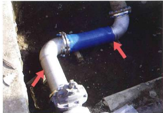
定形曲管では不可能な配管もシナプスフレキと 加工管の組み合わせで可能
