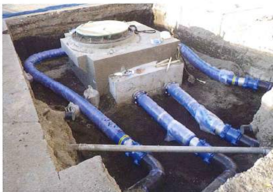
緊急遮断弁と既設管の芯合わせに曲管 および可とう管として使用
