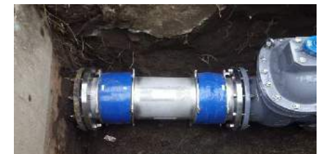
Φ350 既設可とう管取替工事
