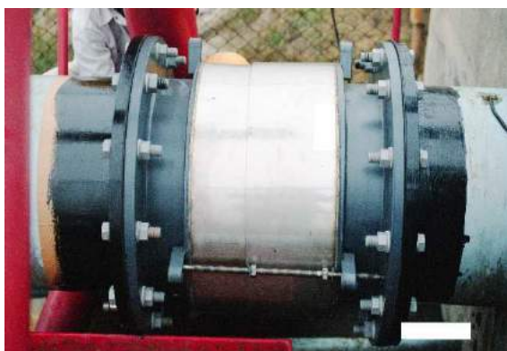
φ 600 塗装仕様品 トラス形式水管橋で使用
