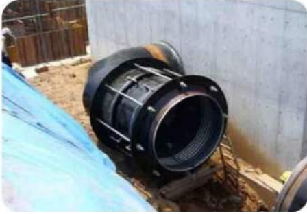
Φ1500 曲管直近にて タイロッド付可とう管を使用
