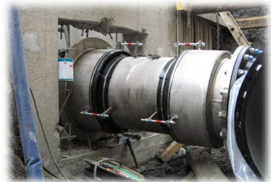
φ600 浄水場埋設部にて使用【MLW】
