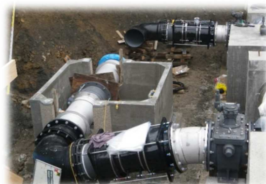
φ350 浄水場内埋設部にて使用【MTLW】
