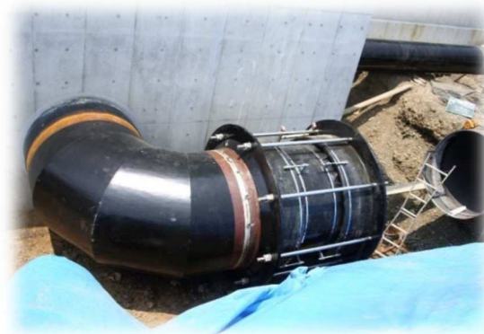
φ1500 浄水場内埋設部にて使用【MTLW】
